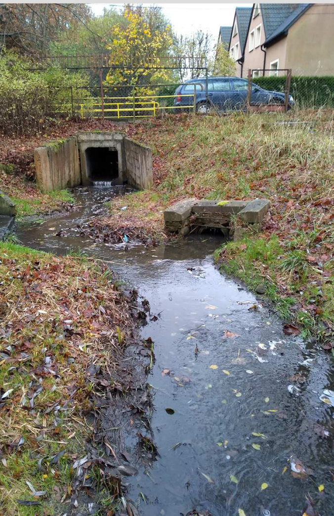
St. 13. Ujście kolektorów nr 5 i 6 do Jeziora Klasztornego Małego
